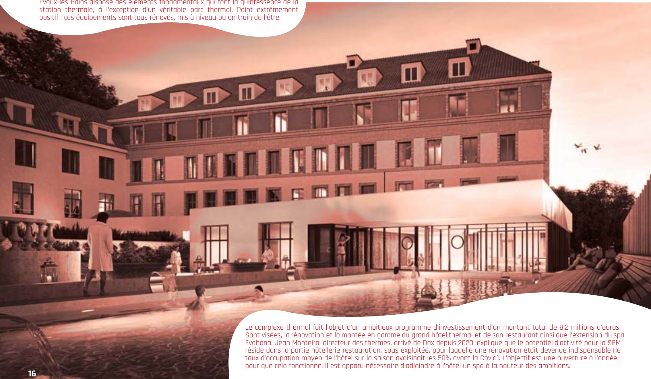
Espace remise en forme / vue extérieure
