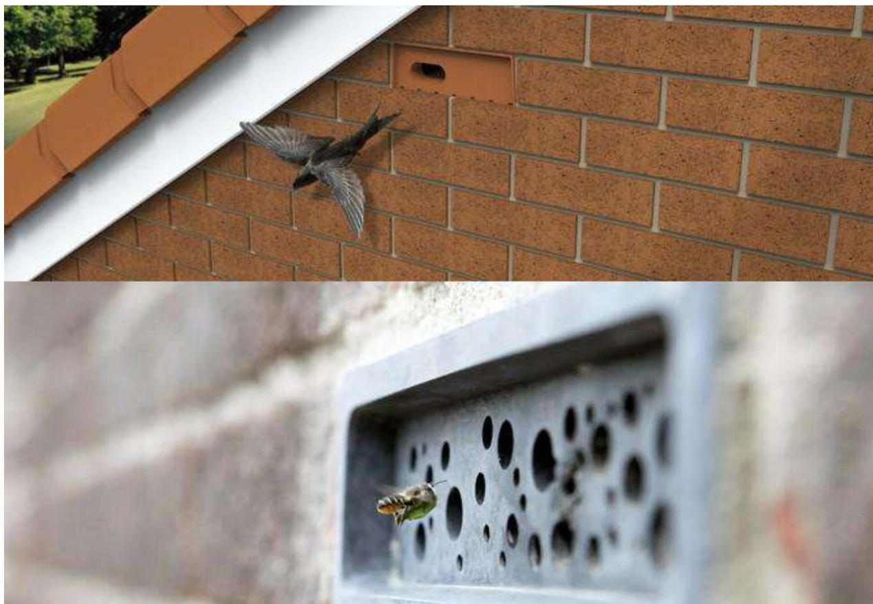
Figure 14 : Exemple de mesures d'intégration de la biodiversité – Brique nichoir pour espèce cavicole en haut, Brique à abeille solitaire en bas (Source internet)
