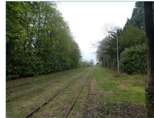
Future voie verte vue depuis l'ancienne gare - © Campus Développement
